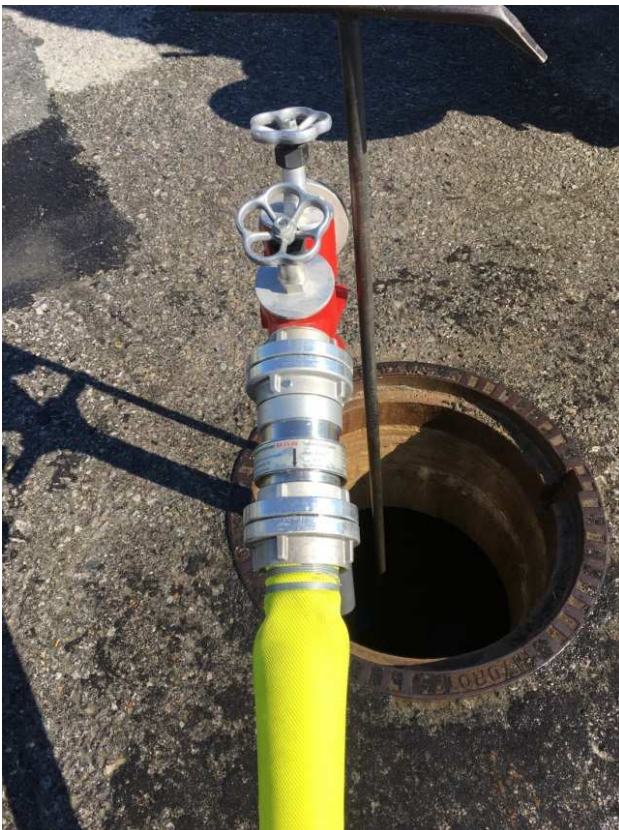
Abb. 4. Feuerwehr-Systemtrenner, montiert am B-Abgang des Standrohres
